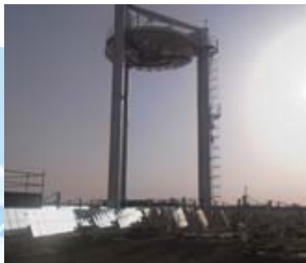
アブダビの太陽熱発電の実証施設
