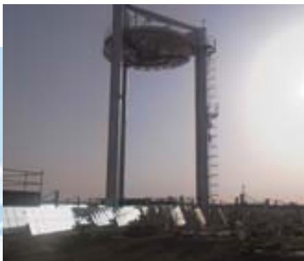
アブダビの太陽熱発電の実証施設
