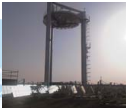
アブダビの太陽熱発電の実証施設
