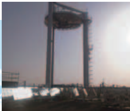
アブダビの太陽熱発電の実施設
